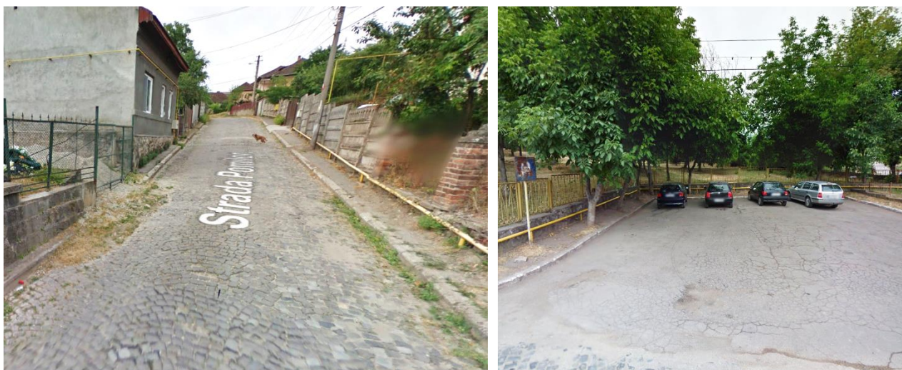
Figura 32 - Drum și parcare în imediata vecinătate a Castelului, în stare foarte avansată de degradare
