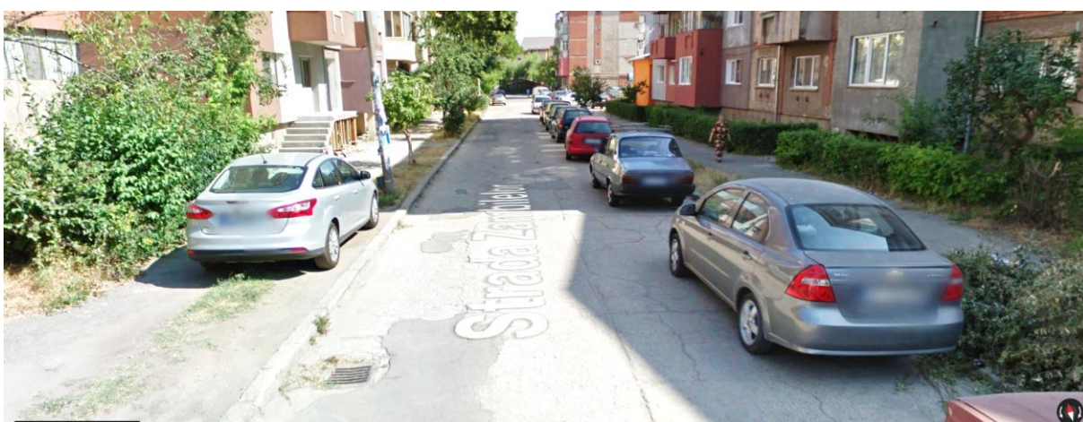
Figura 31 - Strada Zambilelor: stradă în stare rea, cu profil îngust ce poate fi transformat în ocazional carosabil (trama secundară). Parcare ad-hoc pe aliniamentul verde. Sursa – Google Maps
