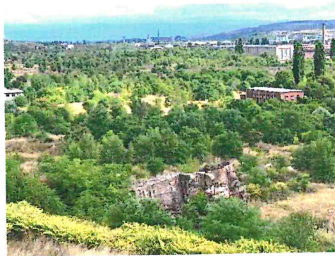
Ziduri de sprijin
