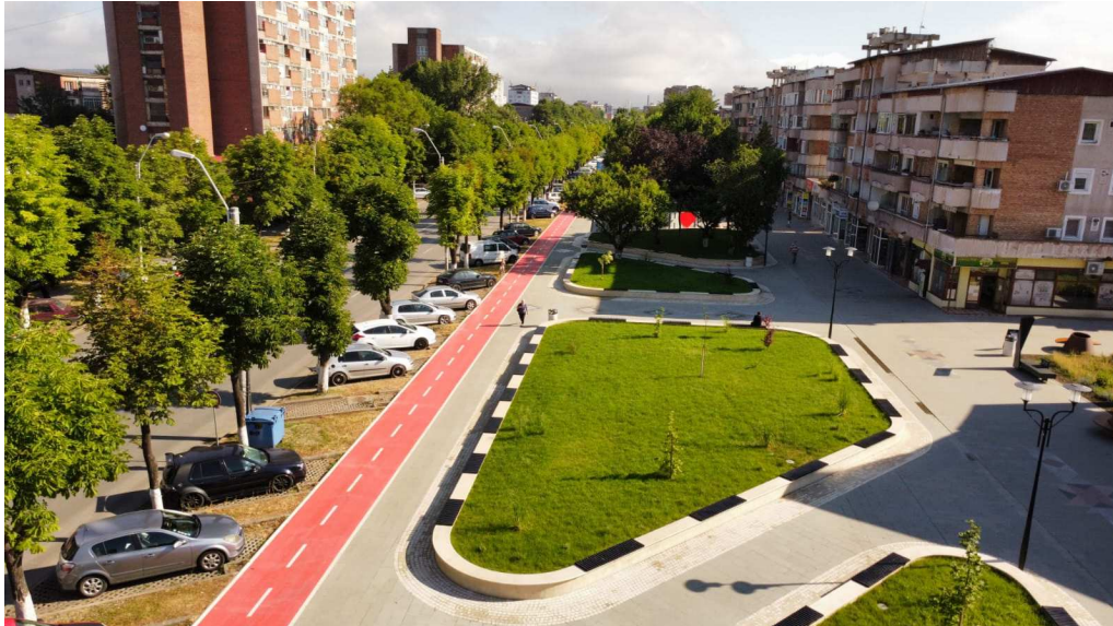
(Zona pietonală Sanitas după reabilitare și modernizare)
