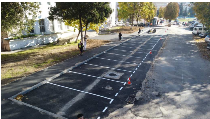
(Parcare reabilitată în zona „Poșta Veche”)
