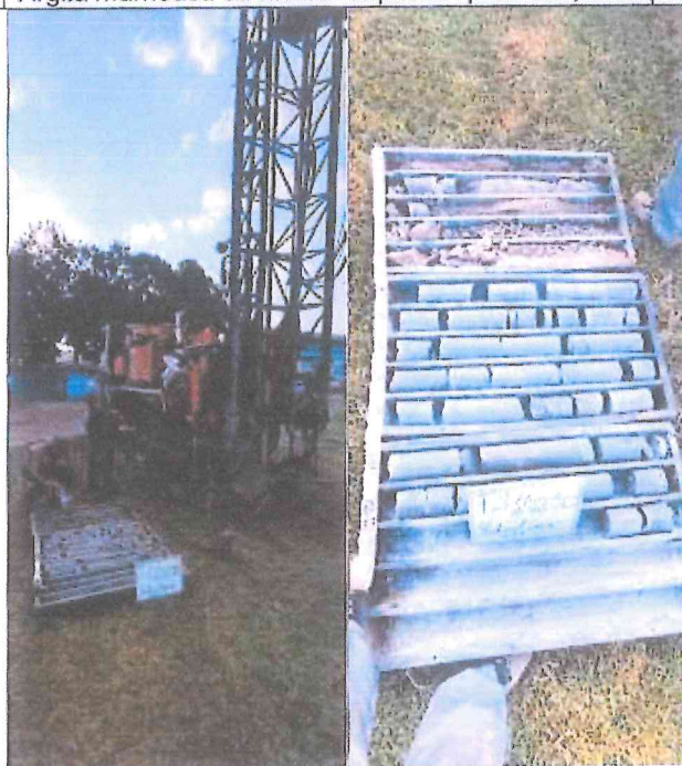
F3 (2025) -12 m / a interceptat următoarea litologie, executat conform plan de situație,
