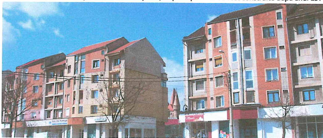
Figură 42 Blocurile de pe strada Elisabeta Mărgineanu, ce obturează vederea spre castel
