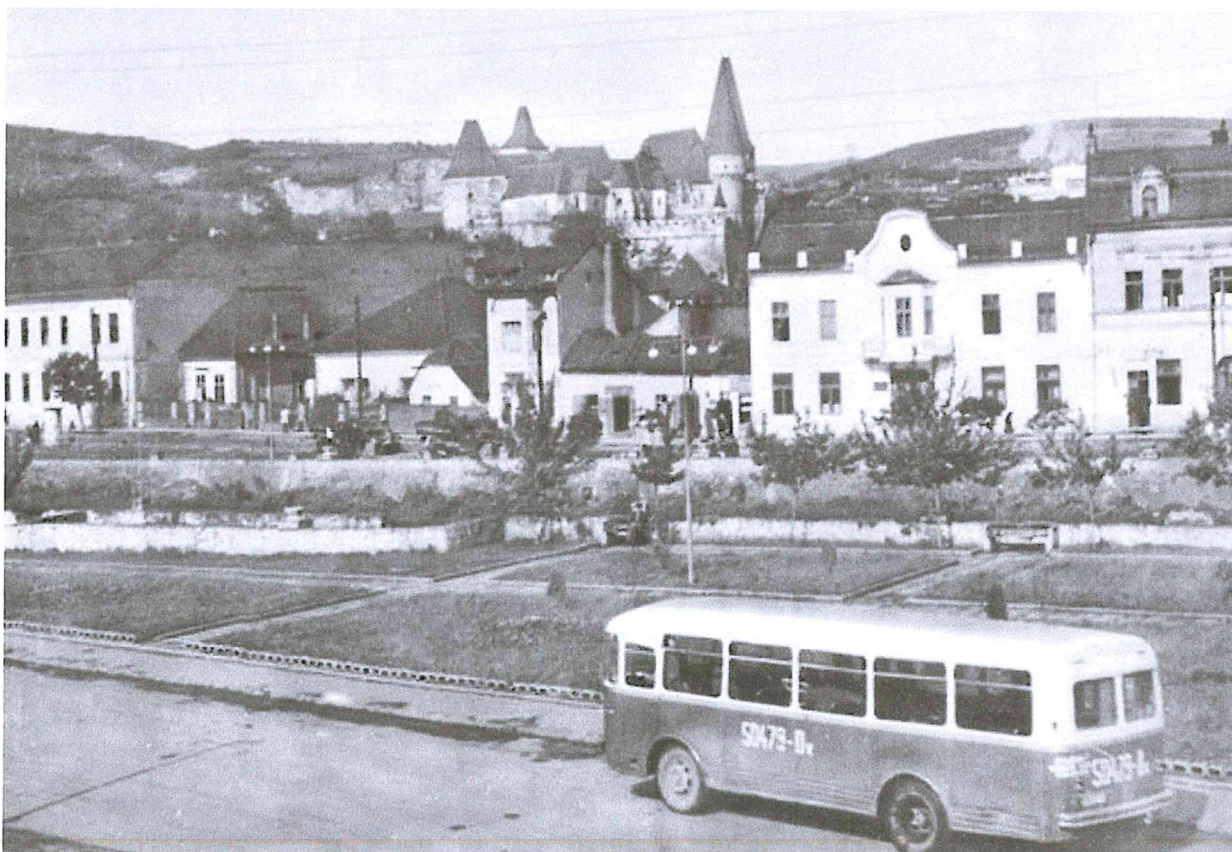
Figură 30 Clădiri ce au fost demolate pentru construcția de locuințe colective
