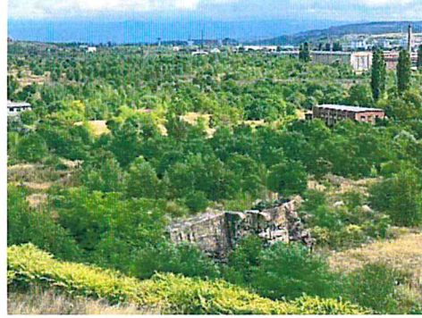
Ziduri de sprijin
